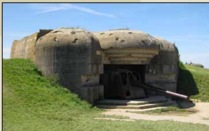
▲ Eén van de vier grote bunkers in Longues-sur-Mer
